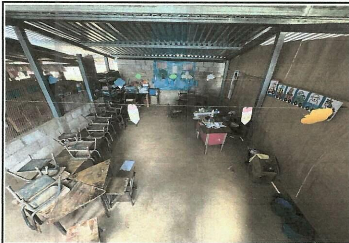
Foto1: Mejoramiento de pared en el aula
