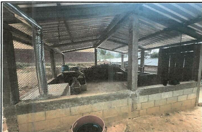
Foto 3: Mejoramiento de pared en la cocina
