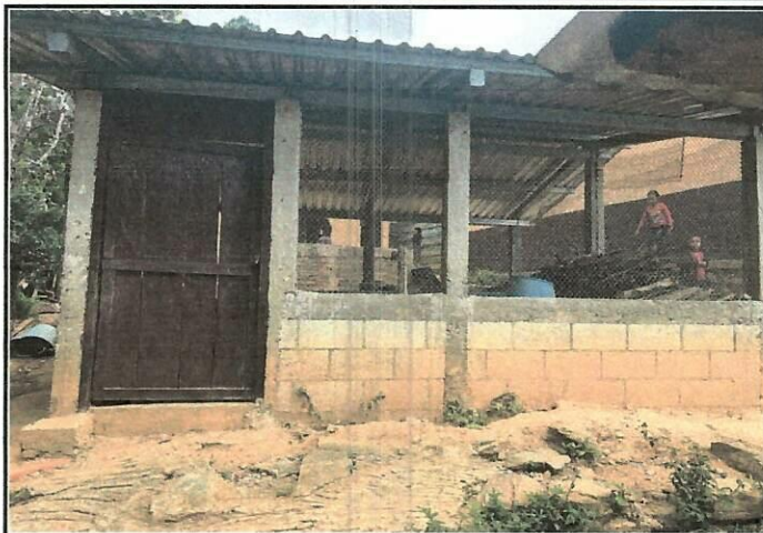
Foto 2: Mejoramiento de pared en la cocina
